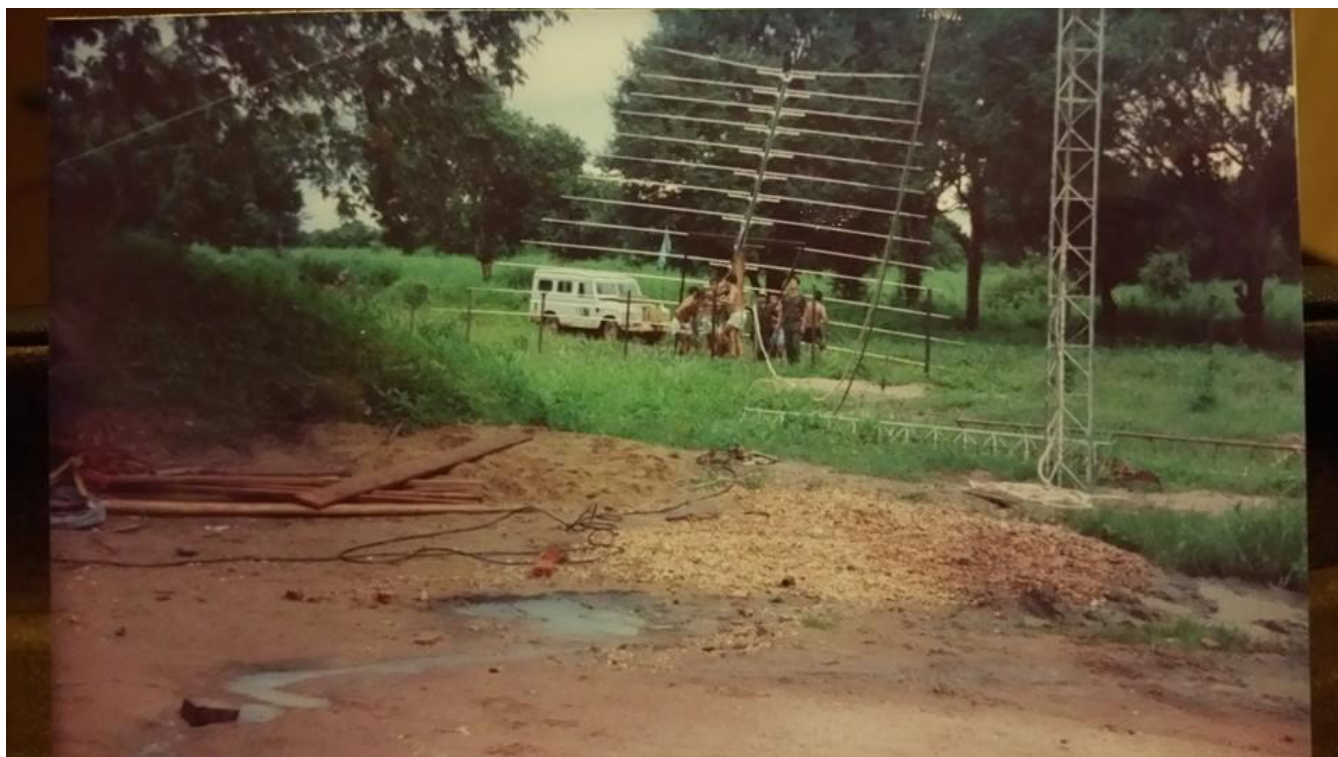
Instalando la antena logarítmica periódica en Camboya 1992
