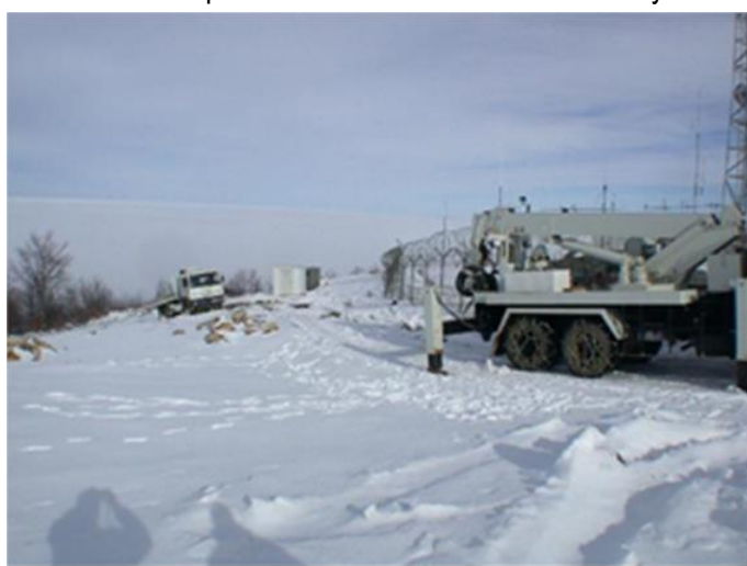
El camión grúa tironeando con cable de acero al camión Renault
