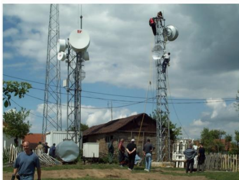
La escuadra de técnicos durante los trabajos de instalación de equipos y antenas
