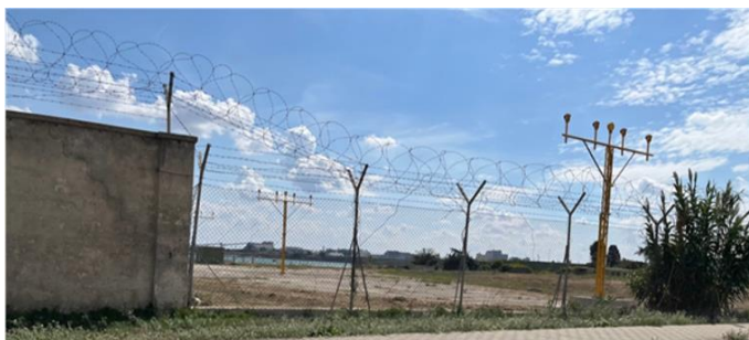
El muro sur también sustituido por una malla metálica.
