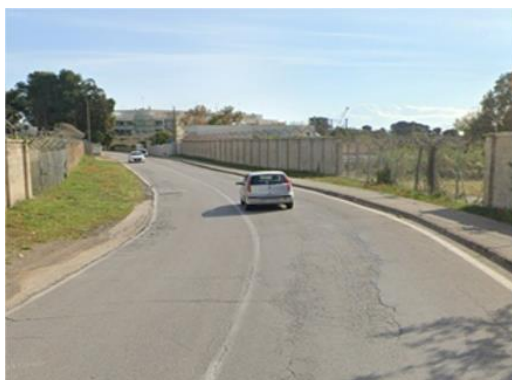
Foto tomada desde la propia avenida con tránsito, nótese los muros faltantes a ambos lados de la calzada, sustituidos con mallas metálicas.
