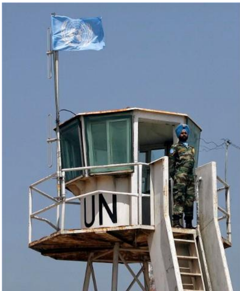
Puesto de Observación UNIFIL Líbano.
